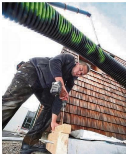
**Präzisionsarbeit:** Die Holzblöcke, die hier Lars Linker befestigt, geben später den Balkenzügen Halt, mit deren Hilfe die Position des Moduls exakt justiert wird.
